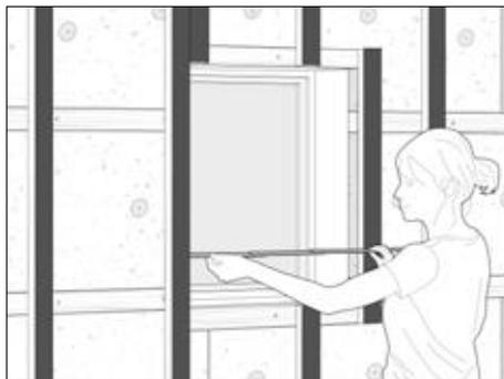
Измерьте ширину оконного проёма для заказа отливов.
