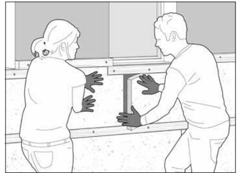
Установите теплоизоляцию в шахматном порядке и заподлицо с горизонтальными брусками.
